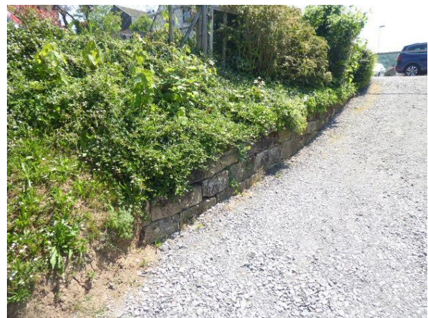
Abb. 3: Zufahrt zu Gebäude auf Flst.-Nr. 371/1 mit Trockenmauer.
