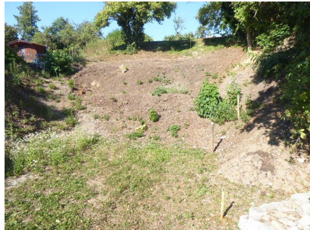
Abb. 13: Böschung westlich Flst.-Nr. 371/1 mit verdorrter Vegetation im August.
